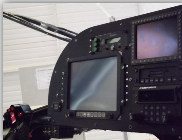
Instalação Monitor AVDU-2655
