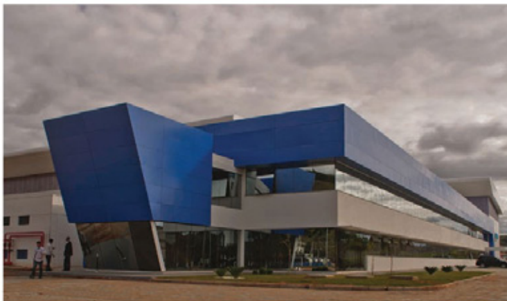
Vista externa da nova fábrica do EC 725
